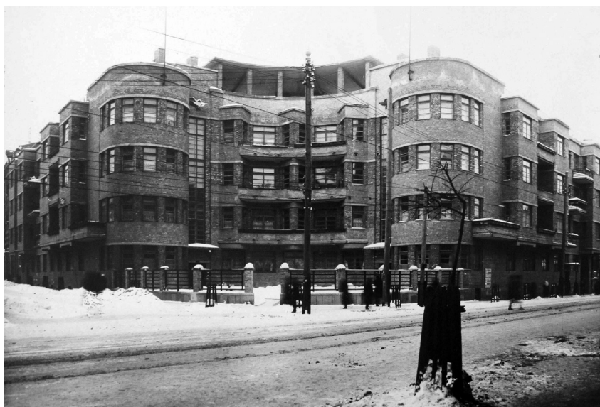
Рис. 2. Перший будинок кооперативу «Радянський лікар» по вул. В. Житомирській, 17/2, в якому у 1930–1961 рр. мешкав архітектор П.Ф. Альошин. Поч. 1930-х рр. ДНАББ ім. В. Заболотного.
