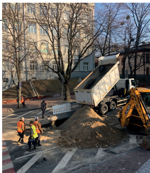
Рис. 27. Ліквідація прориву водогону, що живить музей на вул. Володимирській. 25.06.2022 р. Фото Б. Патриляка
